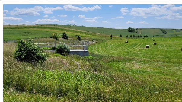
Suchá hráz N3 na Lůčkovém potoce je součástí protipovodňových opatření realizovaných v krajině. Snižuje dopady hydrologických extrémů.
