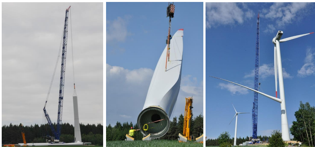
Obrázek 45: Výstavba velké VtE o výkonu 4,2 MW (Gruna - Žipotín, červen 2023), zdroj: vlastní foto
